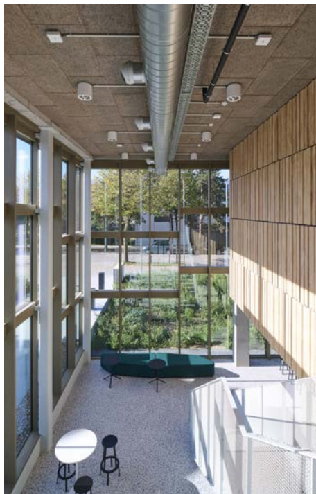
Les murs-rideaux en aluminium d'Aliplast assurent le caractère lumineux, transparent et ouvert du foyer.
