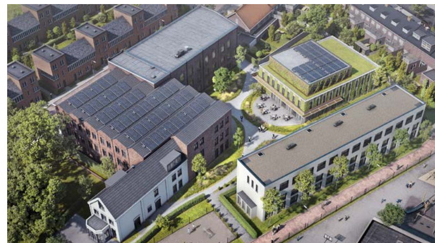
De herontwikkeling van de voormalige sigarenfabriek in Hilversum omvat renovatie van het monument en toevoeging van nieuwbouw rond een groen binnenterrein.
