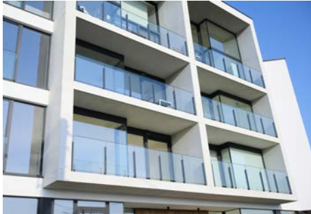
De combinatie van vaste glasvlakken en slanke schuiframen versterkt het gevoel van ruimte en continuïteit tussen binnen en buiten.
