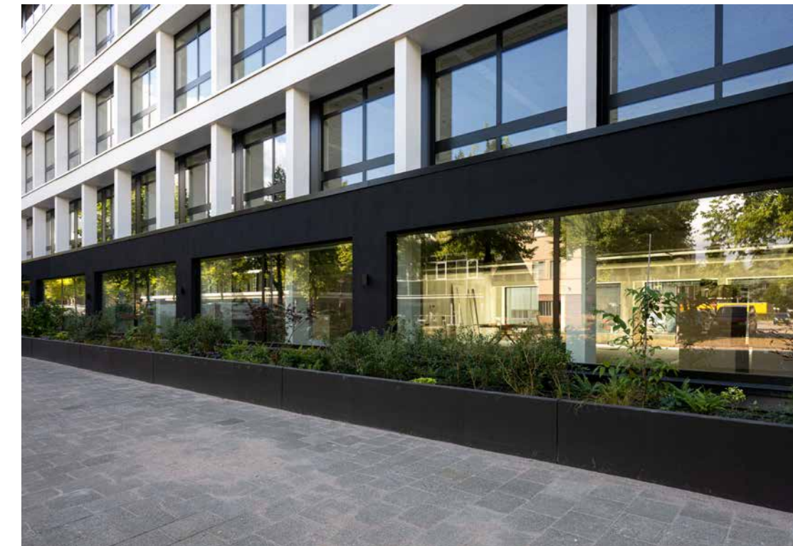
APS Facade verving de oude kozijnen door moderne aluminium kozijnen type Star 75 van Aliplast.
