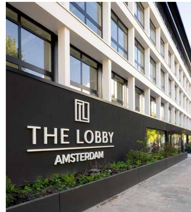
Het oude kantoorpand Zwaansvliet werd getransformeerd, gemoderniseerd en uitgebreid. The Lobby is de nieuwe naam van het stijlvolle kantoorcomplex.
