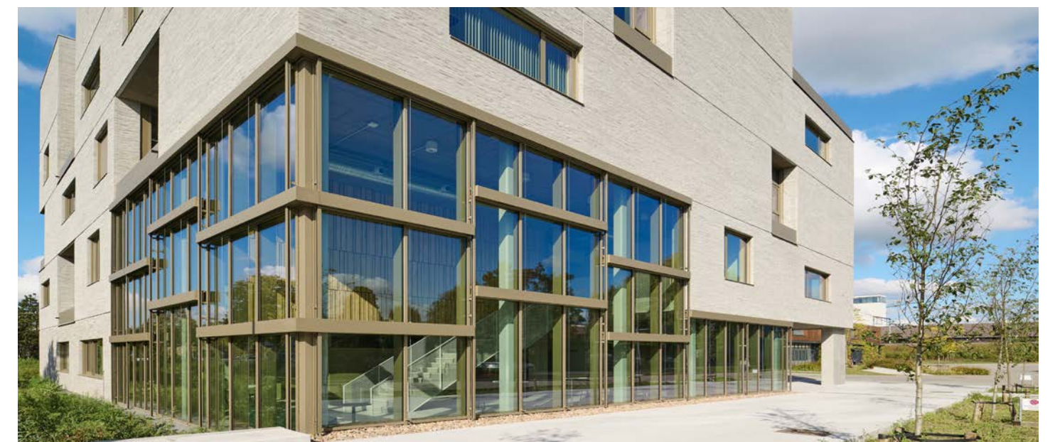
De 7,7 meter hoge glaspertij zonder tussensteunpunten illustreert het technische vakmanschap achter het Aliplast Aluminium MC55-systeem.
